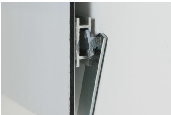
T-Schraube mit Spezienschlüssel verdrehen
