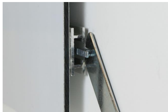
Spezienschlüssel von unten ansetzen
