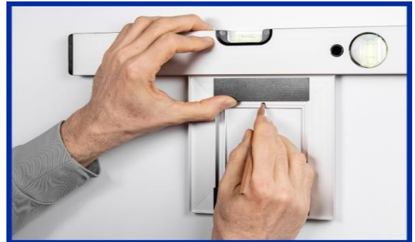
2. Bohrlöcher anzeichnen
