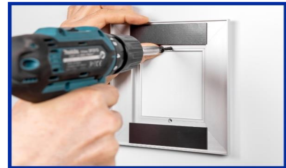
4. Schrauben einsetzen
